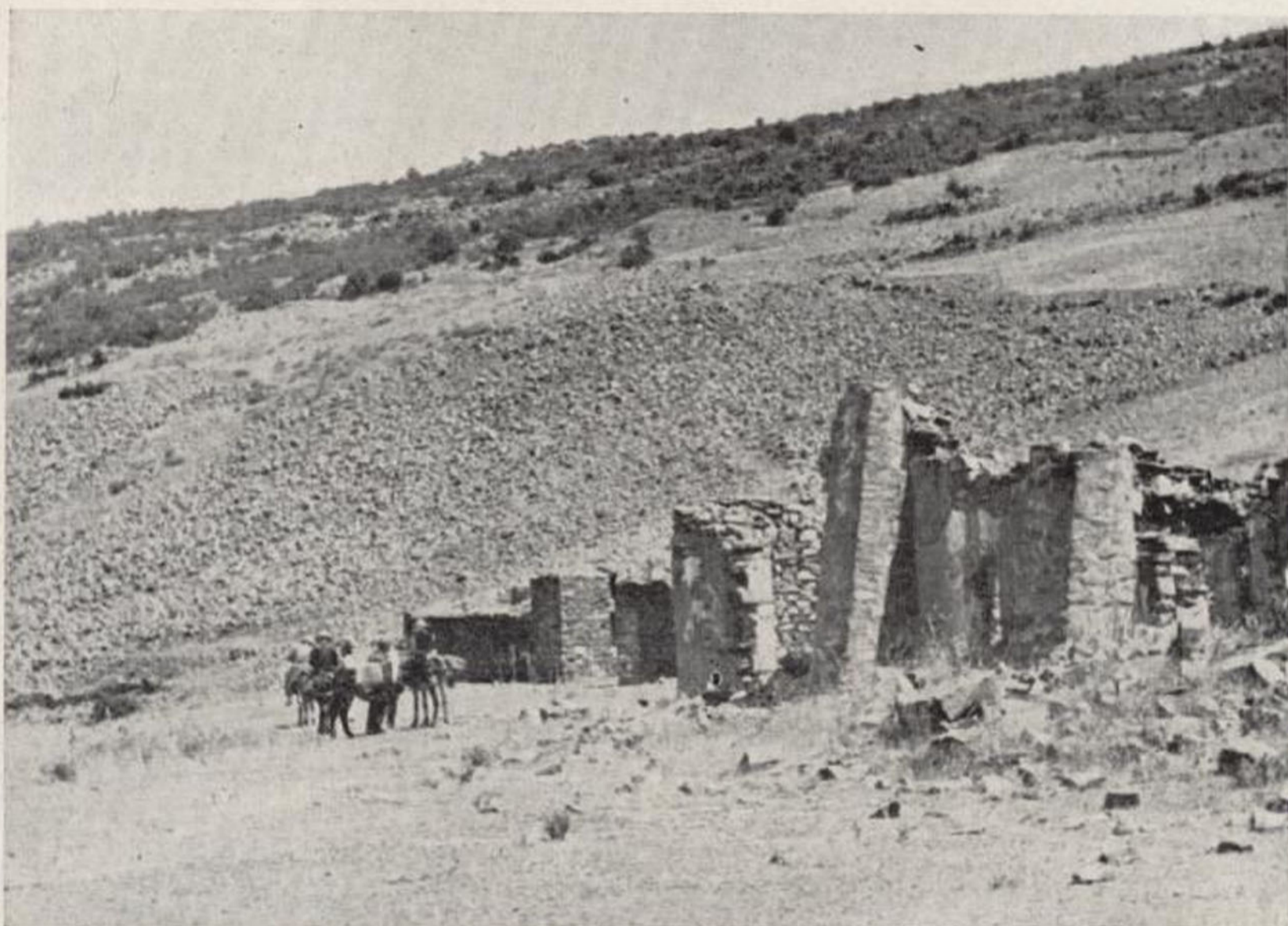
Fot. 3.—Mina «Pilar». Ruinas de las edificaciones de la Sociedad «La Fraternidad».
